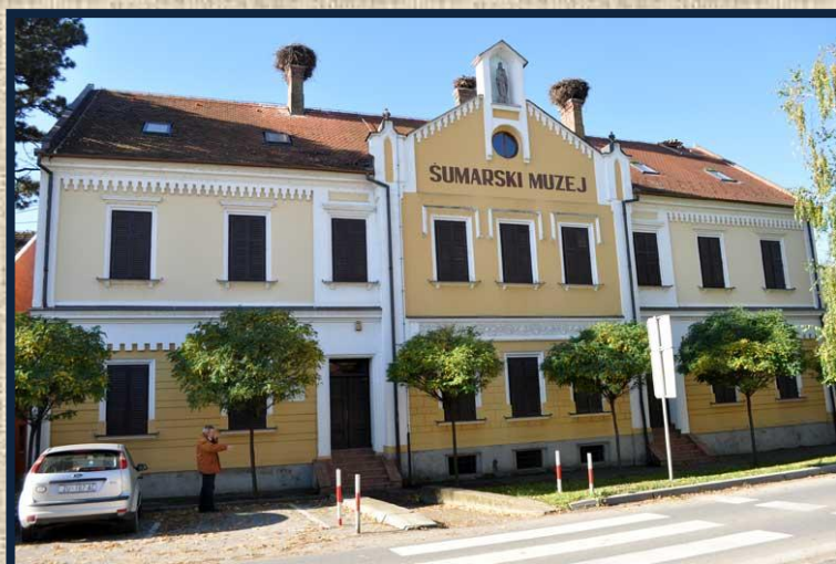
Pročelje zgrade Šumarskoga muzeja
